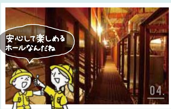
客席の天井裏の様子。2009年の耐震補強を含む大改修で、天井をすべて解体して一新。キャットウォークや照明操作室も安全で丈夫な鉄骨造りに生まれ変わりました。
