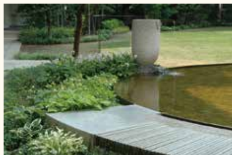
中部大学 25号館中庭「花鏡の庭」(2004年) 庭と広場の中間的空間としてデザイン。円形の池は前方にだけ水が落ちるよう、後方を4mm高くしています。
